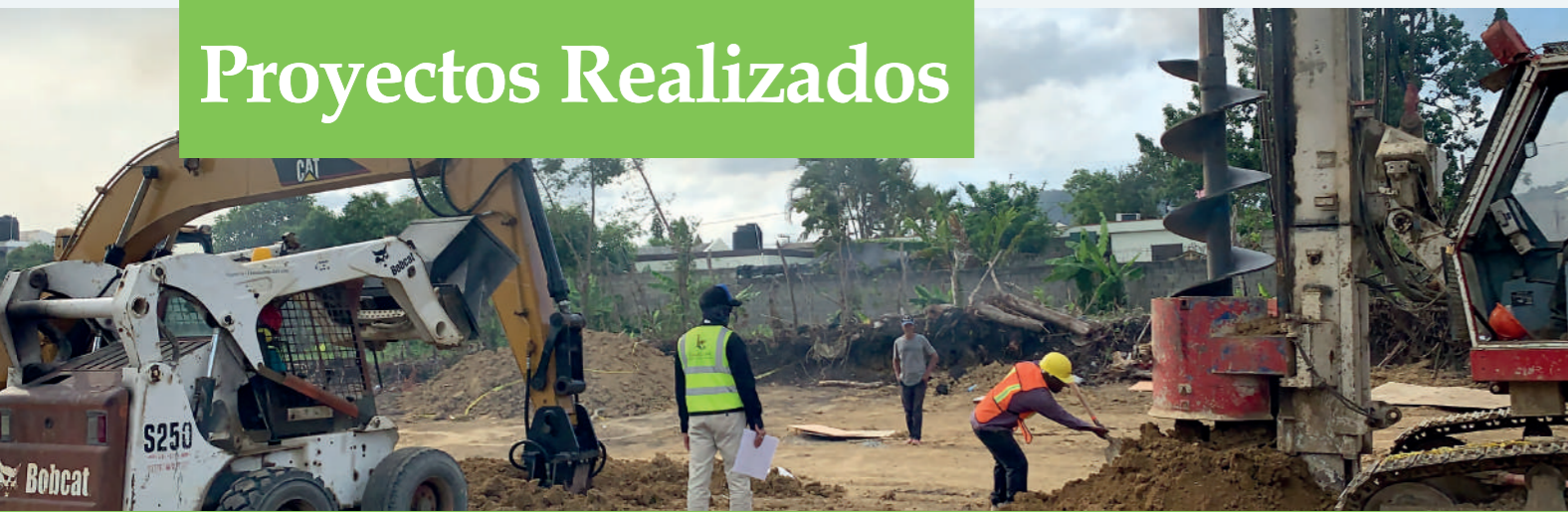
Mejoramiento de suelos por medio de columnas de gravas.
