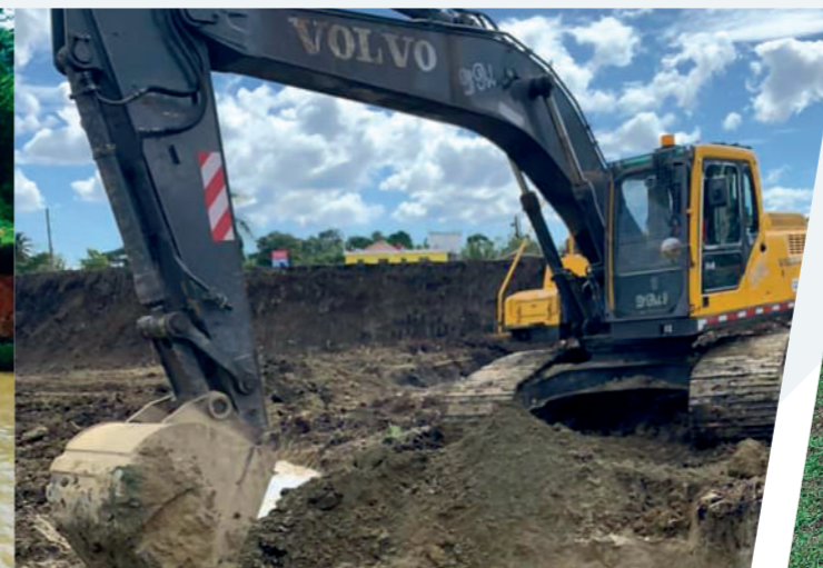
Movimiento de tierra.
