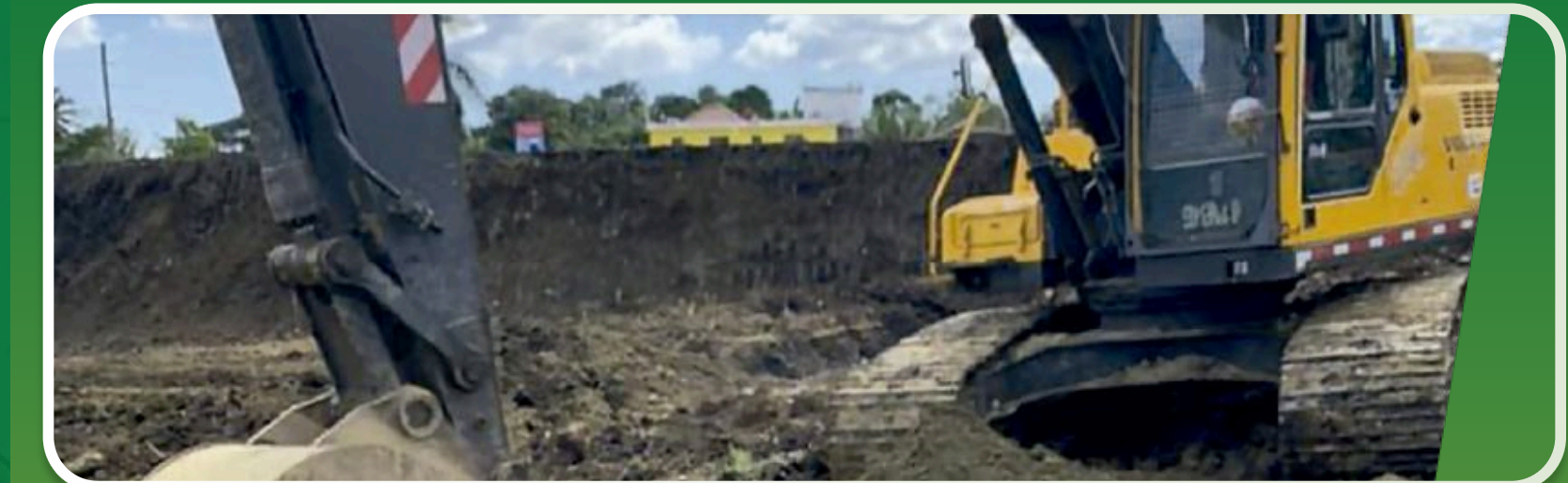
➤ Mejoramiento de suelo por medio de sustitución de material
