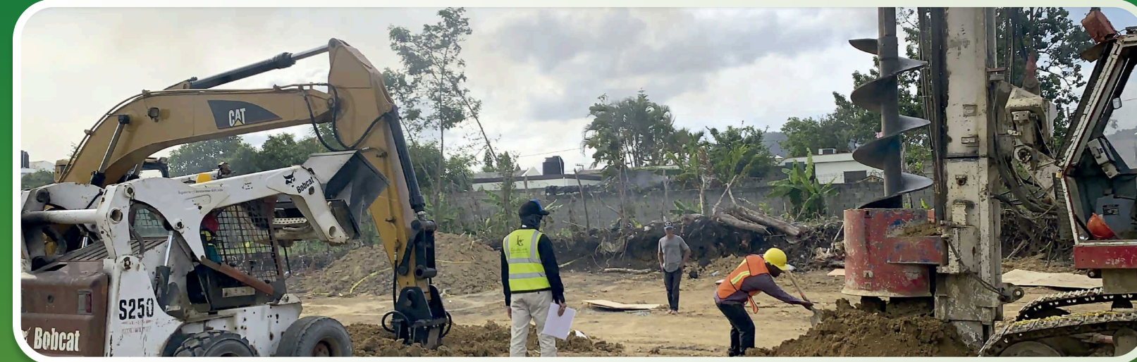
➤ Mejoramiento de Suelos por medio de columnas de gravas
