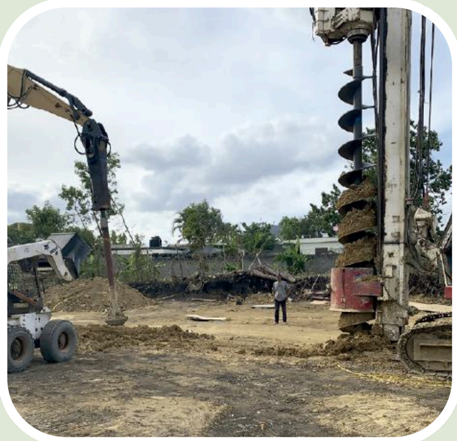
Ejecución de pilotes y micro-pilotes.
