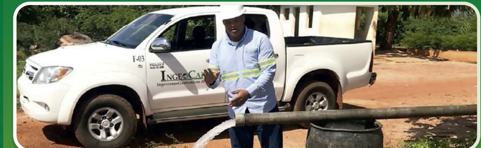
➤ Perforación de pozos y captación de aguas subterráneas
