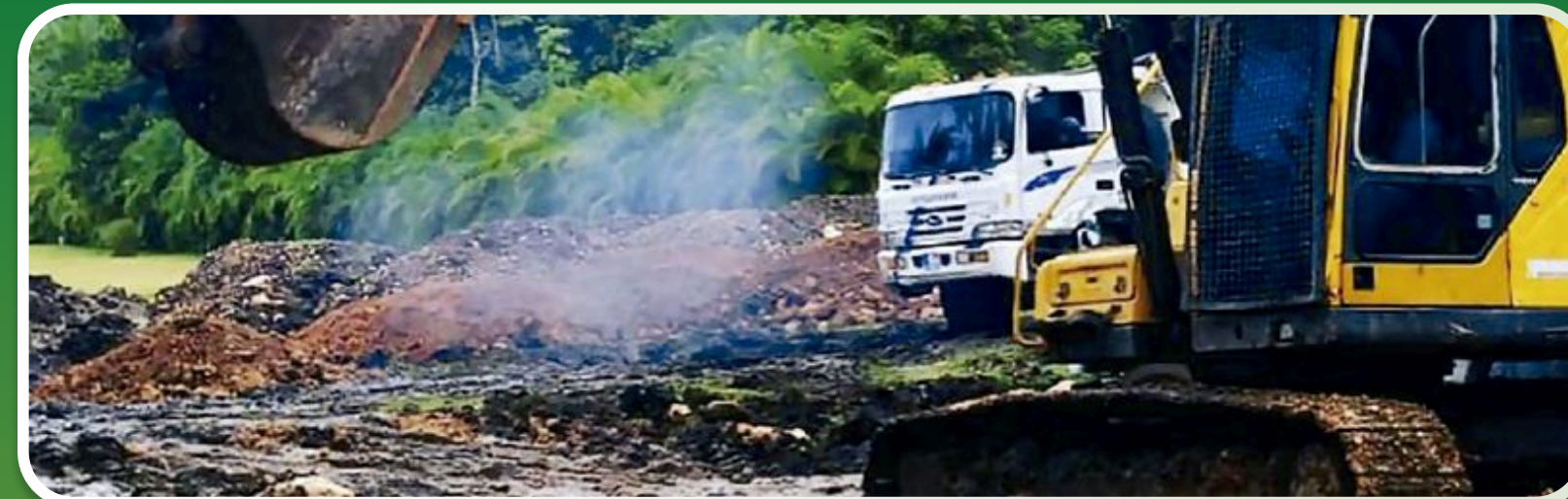
➤ Mejoramiento de suelo por medio de sustitución de material
